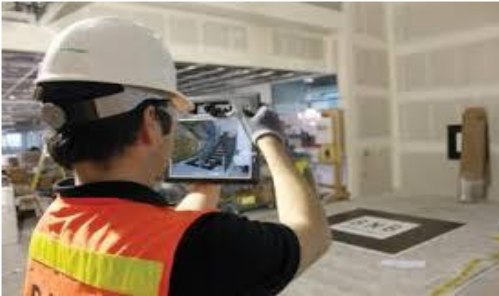
Figura 16: RA na Inspeção da Construção.
